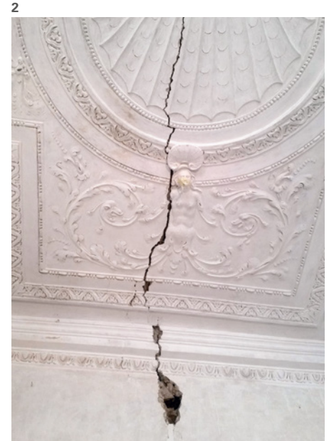
2 In mehreren Räumen wurden statische Risse festgestellt. Die Sanierung erfolgte durch den Einbau von Spiralankern. Die Risse wurden geschlossen und mit Injektionsmörtel hinterfüllt
